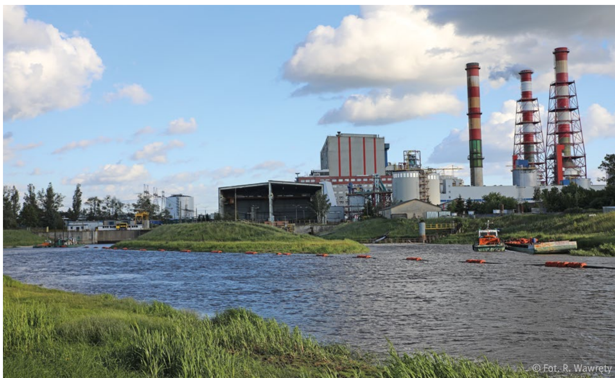
Fot. 22. Ujęcie wody (po lewej) i kanał odprowadzający wody pochłodnicze (po prawej) Elektrowni Ostrołęka.
