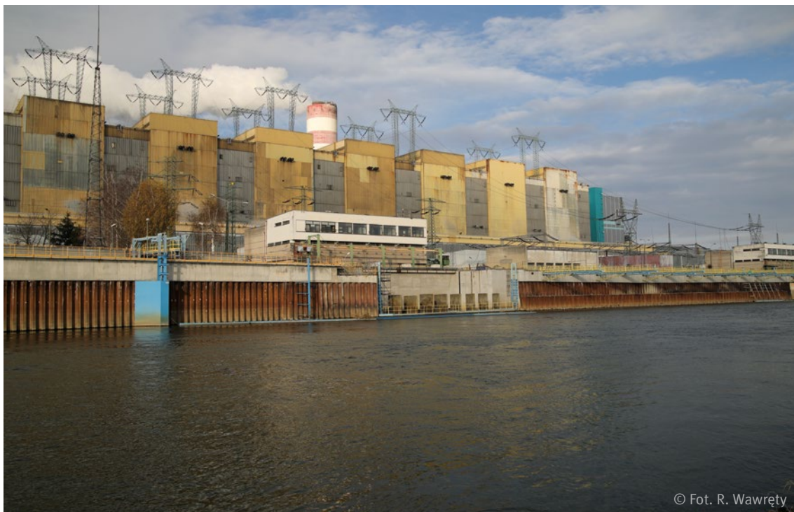
Fot. 23. Ujęcia brzegowe wody Elektrowni Połaniec.
