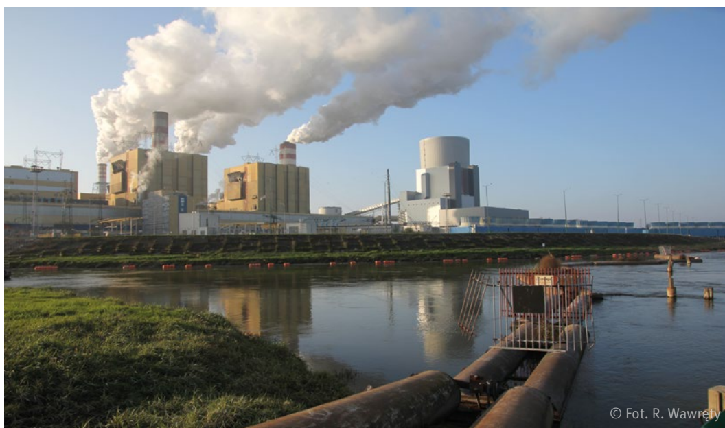
Fot. 19. Widok na kanał ujęcia wód dla Elektrowni Kozienice.
