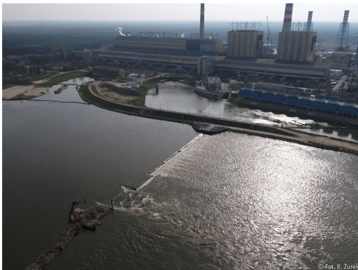
Fot. 6. Widok na ujęcie wód oraz kanał odprowadzający wody pochłodnicze Elektrowni Kozienice.
